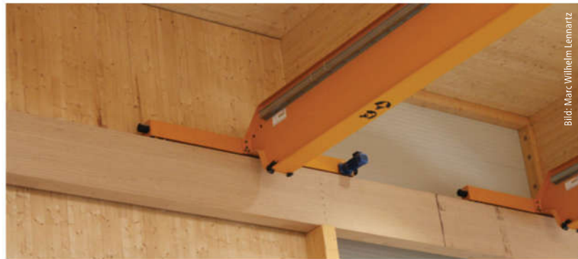
Die Kräne laufen auf Kranbahnträgern aus Buchen-Furnierschichtholz, das gegenüber normalem BSH eine doppelt so hohe Biegezugfestigkeit und eine um etwa 30 Prozent höhere Schubfestigkeit bietet. Zudem sind die hölzernen Kranbahnträger leiser und erzeugen weniger Schall als stahlgeführte.
