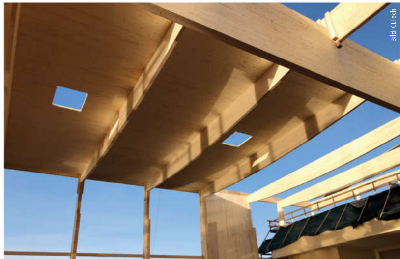
Die als Scheibe ausgebildete Decke setzt sich aus kraftschlüssig miteinander verbundenen, 8 cm dicken BSP-Elementen zusammen. Der horizontale Lastabtrag erfolgt über die BSH-Stützen in die Stahlbetonfundamente. Dabei wurden die BSP-Dachelemente als Dreifeldträger mit einer Gesamtlänge von bis zu 17,50 m ausgebildet.
