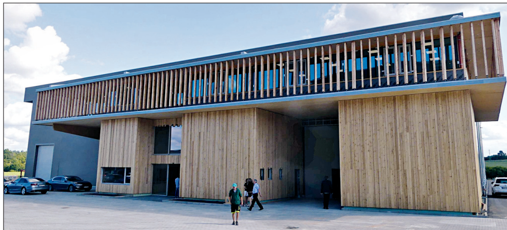
Die Außenansicht des Neubaus einer 4200 m 2 großen Produktionshalle für CL-Tech betont auf der Frontseite den Holzbau und geht zu den Seiten des Baukörpers in eine schlichte Verkleidung aus Stahl-Sandwichelementen über. Fotos: J. Härer
