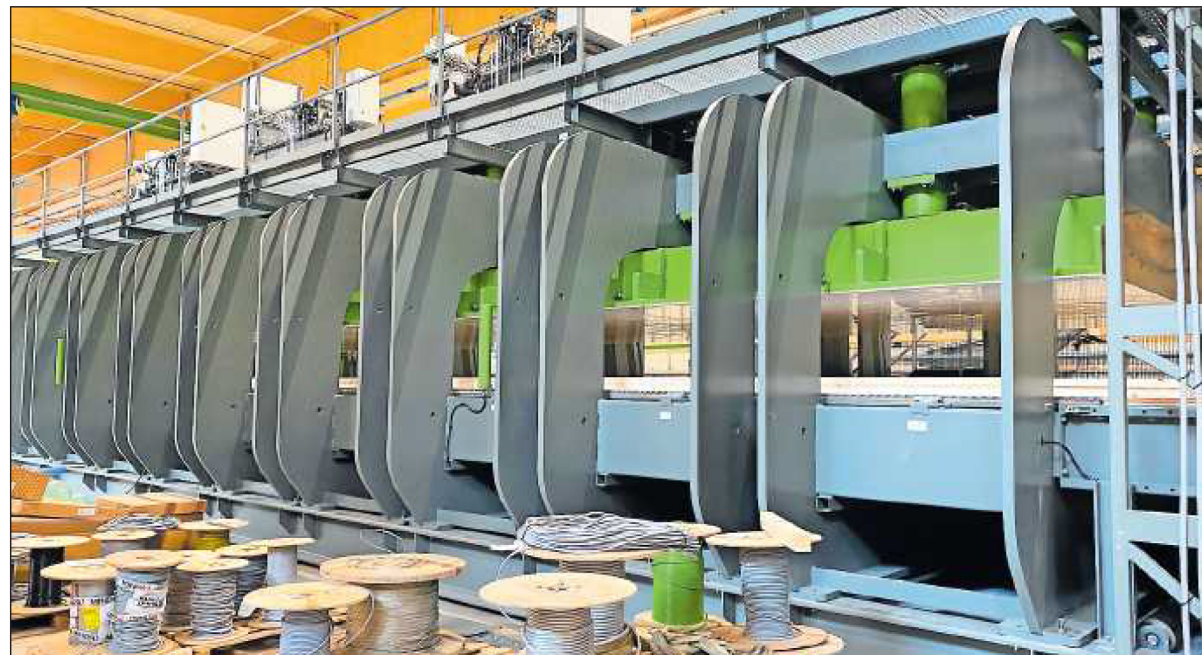
An dieser Presse werden künftig die Brettsperrholz-Platten in der neuen Produktionshalle gefertigt. CL Tech investiert in die Firmen-Erweiterung insgesamt etwa 44 Millionen Euro. Künftig sollen pro Jahr zwischen 30.000 und 35.000 Kubikmeter Holz verarbeitet werden.
