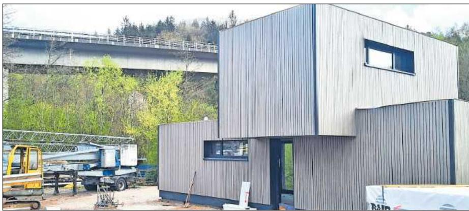
So sehen die Tiny-Haus-Module nach kurzer Aufbauzeit aus. Anschlüsse für Strom, Wasser, Abwasser sind vorbereitet. Mittels Solarmodulen auf dem Dach lässt sich Strom erzeugen und im Batteriespeicher nutzen. FOTO: GOTTSCHALL/FREI
