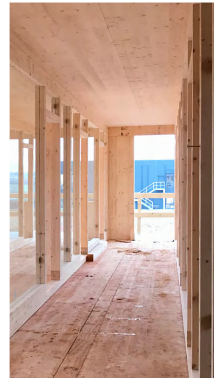
Auch Innenwände und Decken werden vorgefertigt.
