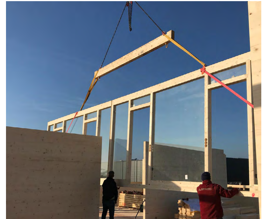
Mit Hilfe von Vorfertigung lässt sich die Fertigungsgeschwindigkeit auf der Baustelle extrem steigern. Ganze Bauteile werden fertig angeliefert – und müssen nur aufgestellt werden.
