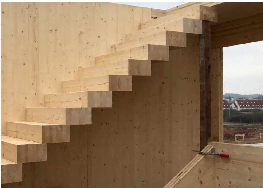
Fix und fertig angeliefert werden auch Treppen und komplette Wände.
